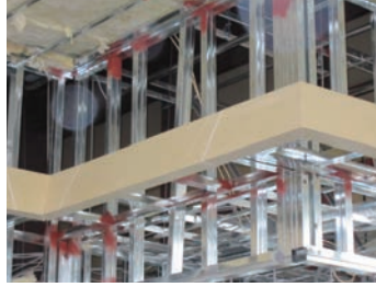
図面に合わせて下地留めする
