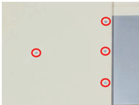
タッピングねじによる固定
